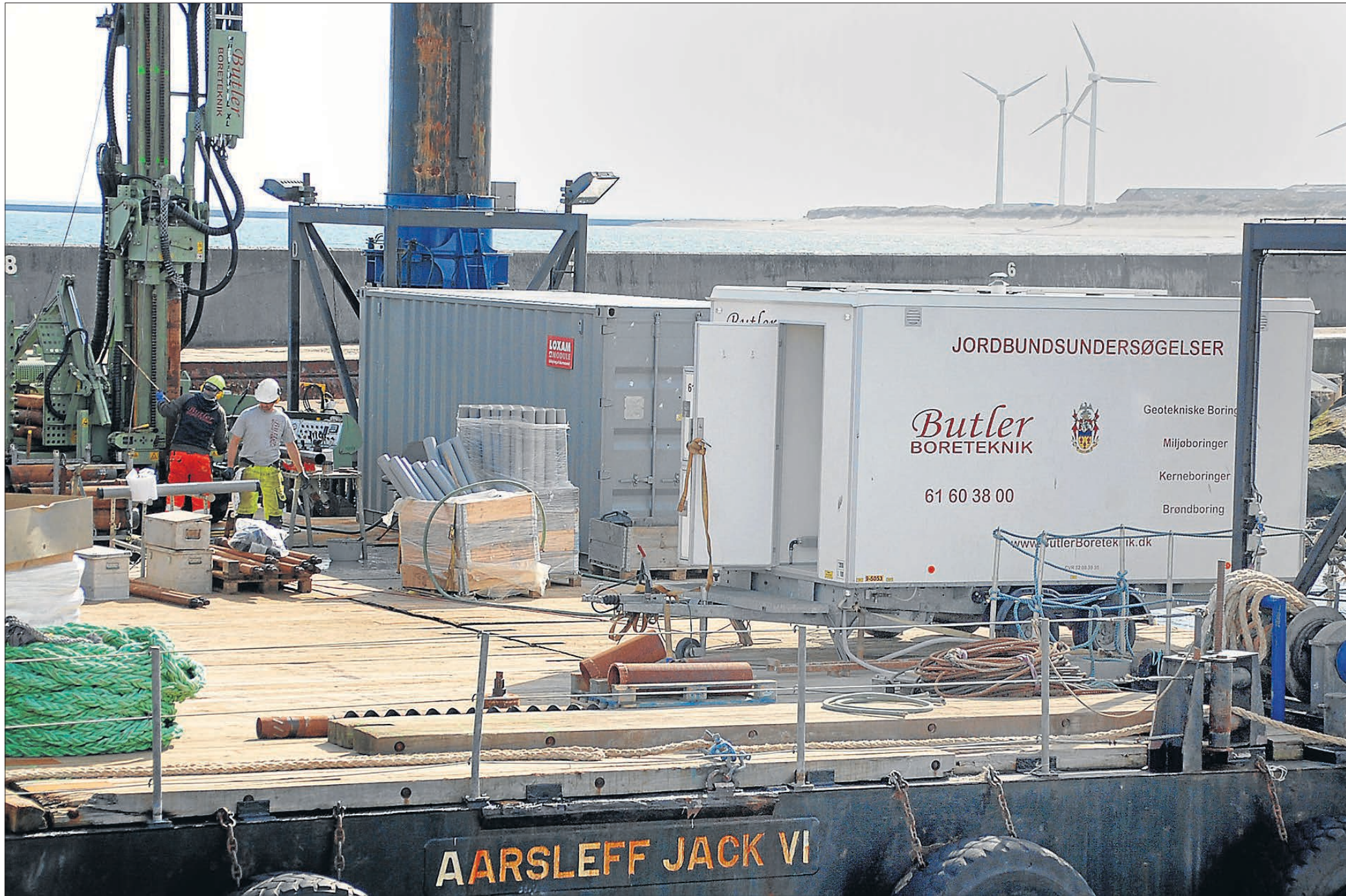
Butler Boreteknik har udført de fleste af kerneboringerne fra en borerig, Jack-up, der er blevet flyttet rundt til specifikke positioner i Hanstholm Havn.
