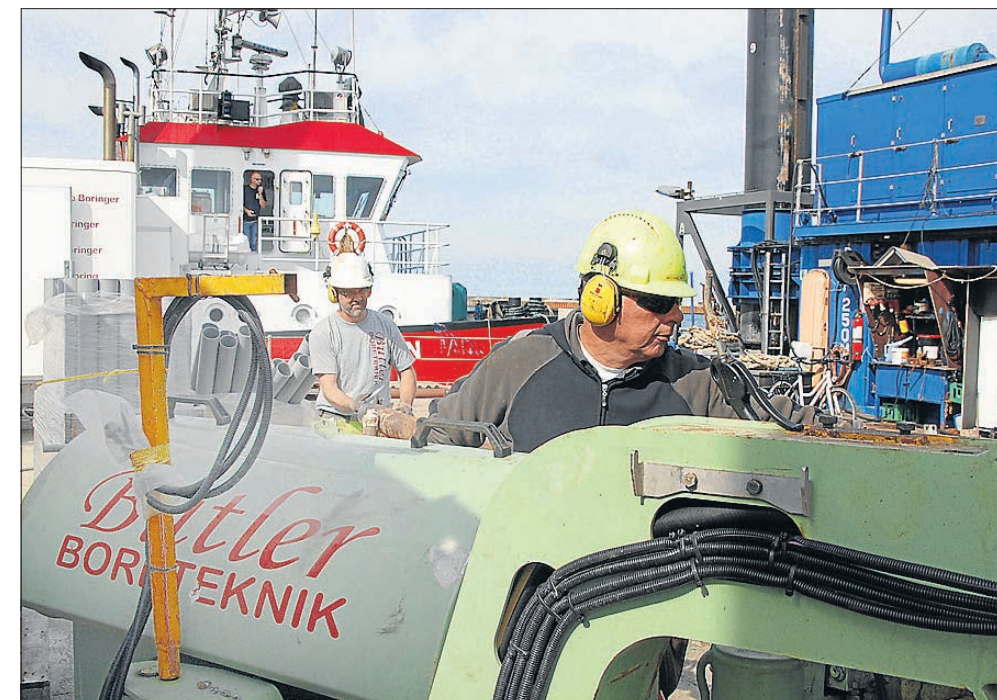
Arbejdet med at hente prøver op af undergrunden er gået gnidningsfrit og uden tekniske problemer med selve borearbejdet (i baggrunden slæbebåden "Dolphin", der sejler medarbejderne frem og tilbage til havnen - og i øvrigt har slæbt Jack-up'en til Hanstholm).
