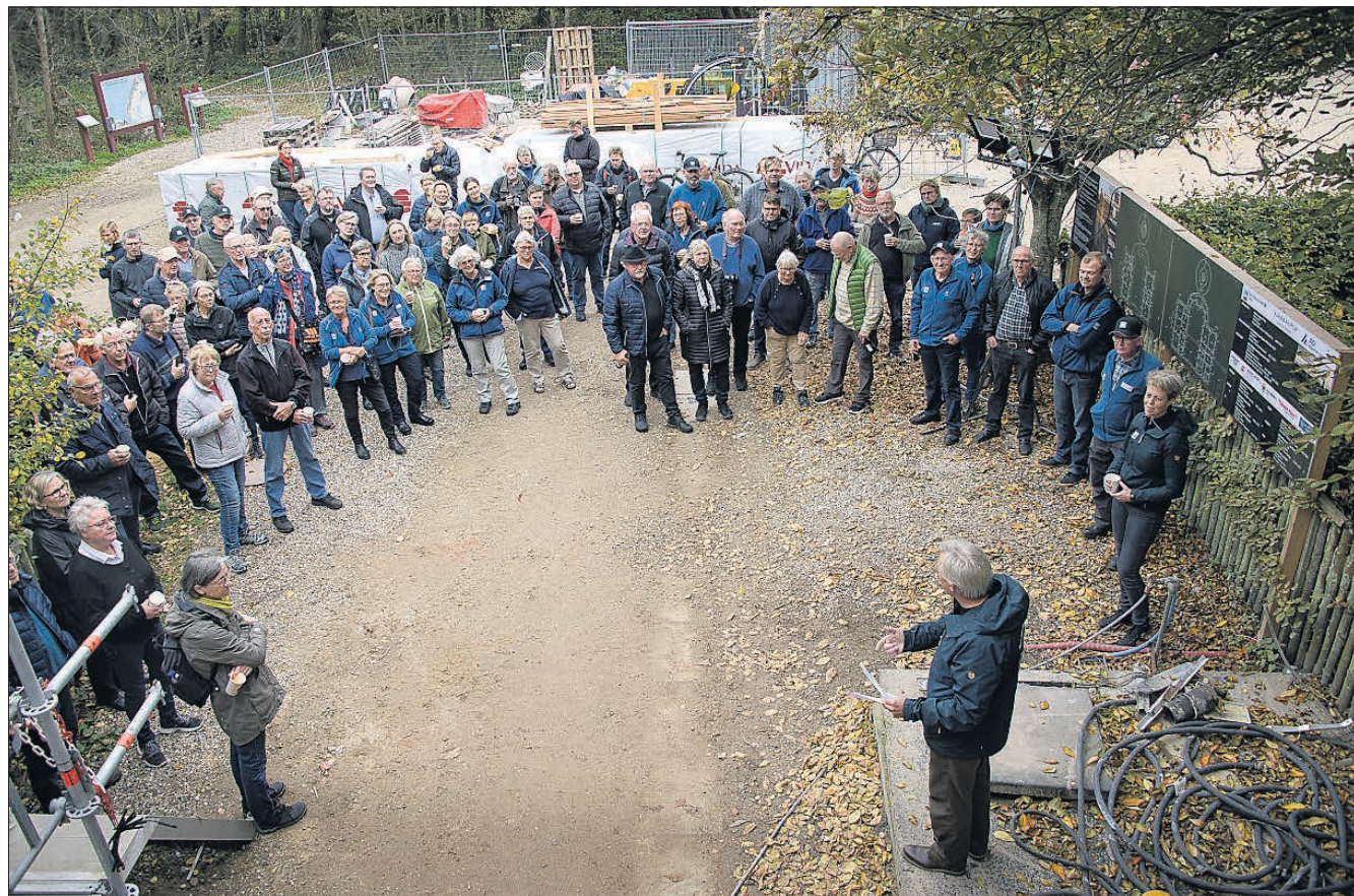
I efteråret kunne interesserede få et indtryk af fremdriften i arbejdet med at restaurere Lodbjerg Fyr, som bliver en af "trædestenene" i nationalparkens formidlingsprojekt "Trædesten til Naturen". Foto: Bo Lehm
